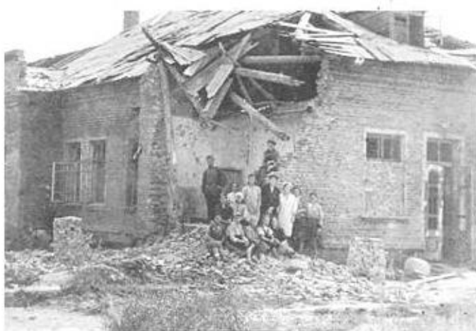
Разрушенное здание гордестанции 1943 г.
